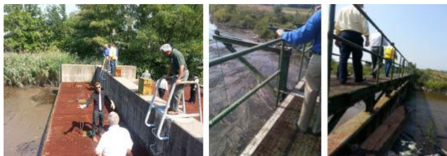
Figura 3-1: Inspección física de la infraestructura de reducción de riesgo existente.
