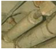
Asbestos pipe lagging
