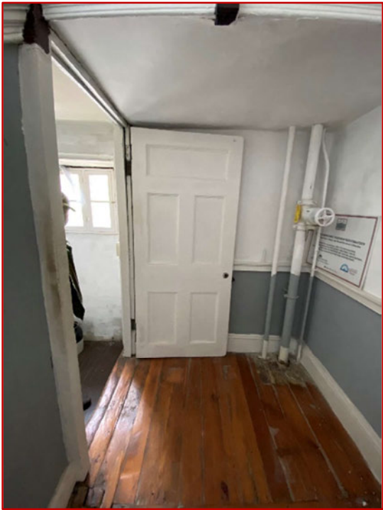
Stair No. 2 Basement Door
