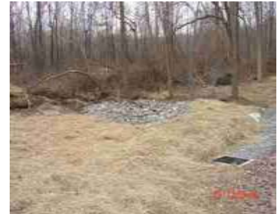
BMP-3 Scour Hole
