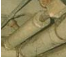
Asbestos pipe lagging
