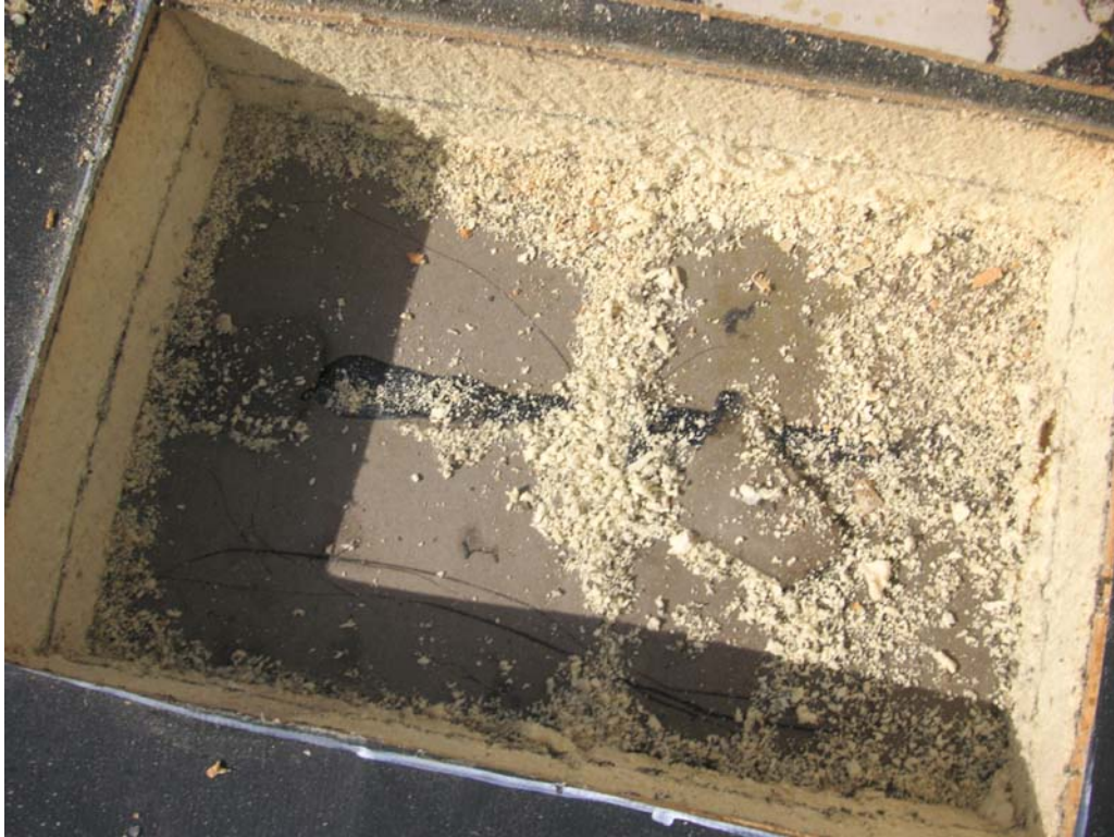
80. Top of bottom layer
